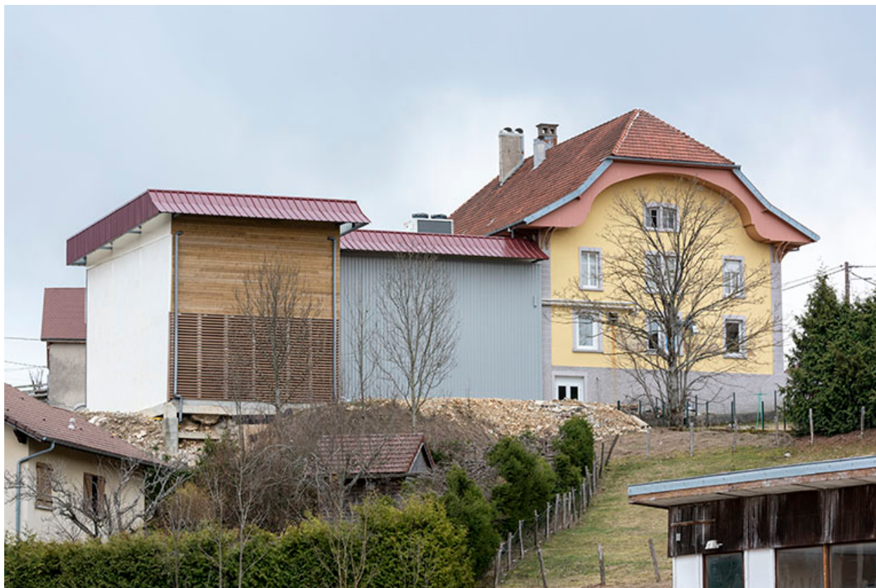
Façade latérale gauche et extension, depuis l'ouest.
