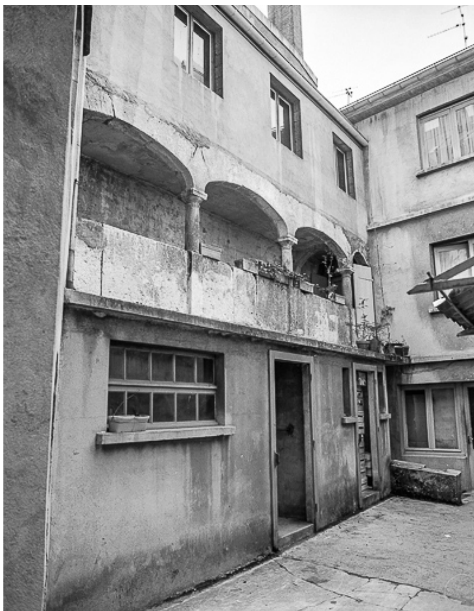
Galerie sur cour intérieure.
