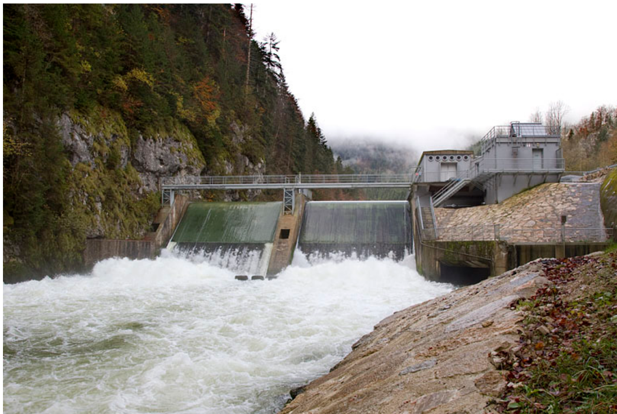
Barrage, vu d'aval.
