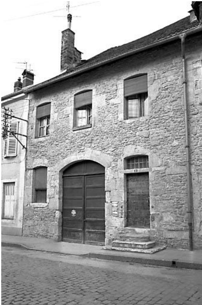
Maison située 8 rue Saint-Laurent.
