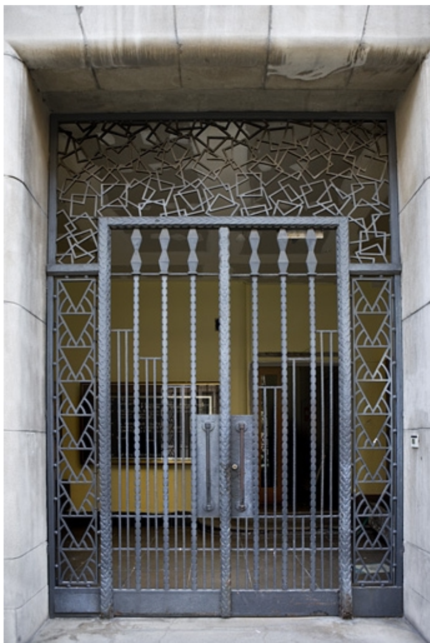
Portail d'entrée : détail de la grille.
