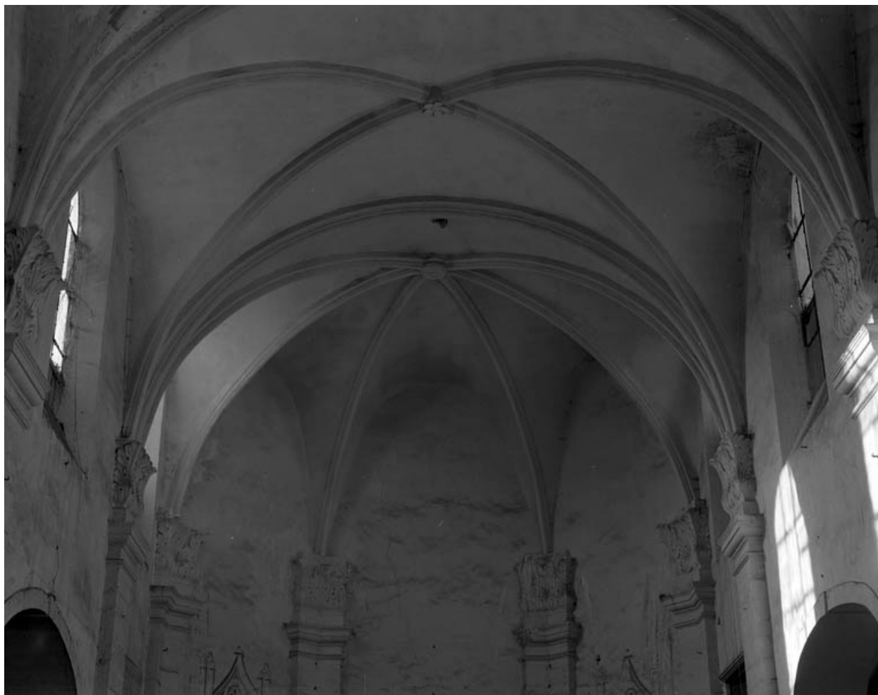
Chapelle : intérieur, voûtes du choeur en 1989.
