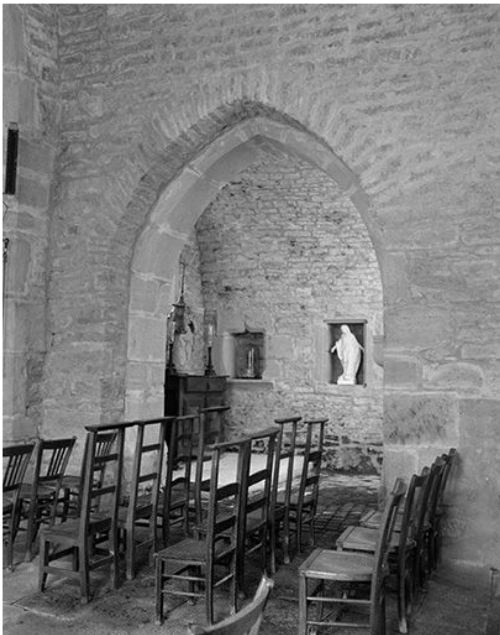
Arc d'entrée de la chapelle latérale.
