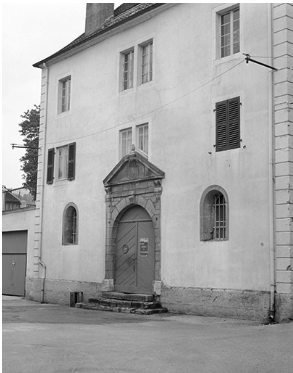
Façade sur la rue Jeanne d'Arc.
