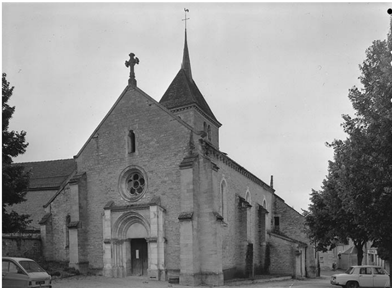
Façade occidentale avec portail.
