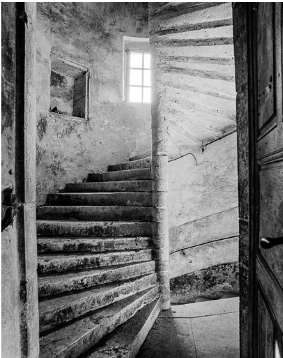
Corps de logis, l'escalier.
