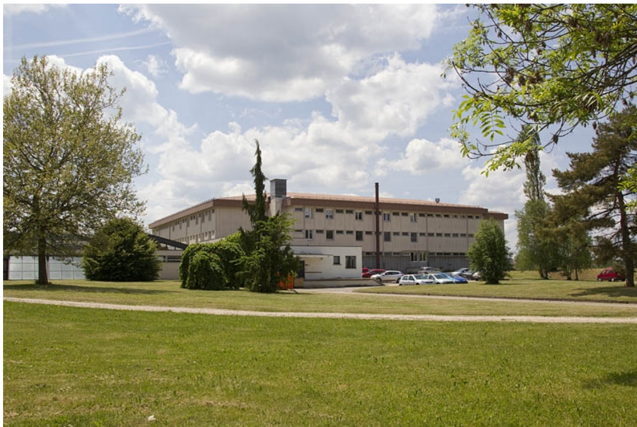
Bâtiment de l'internat ouest, vu du nord.
