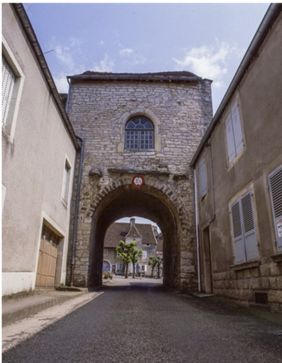
Porte Saint-Hilaire : façade extérieure.
