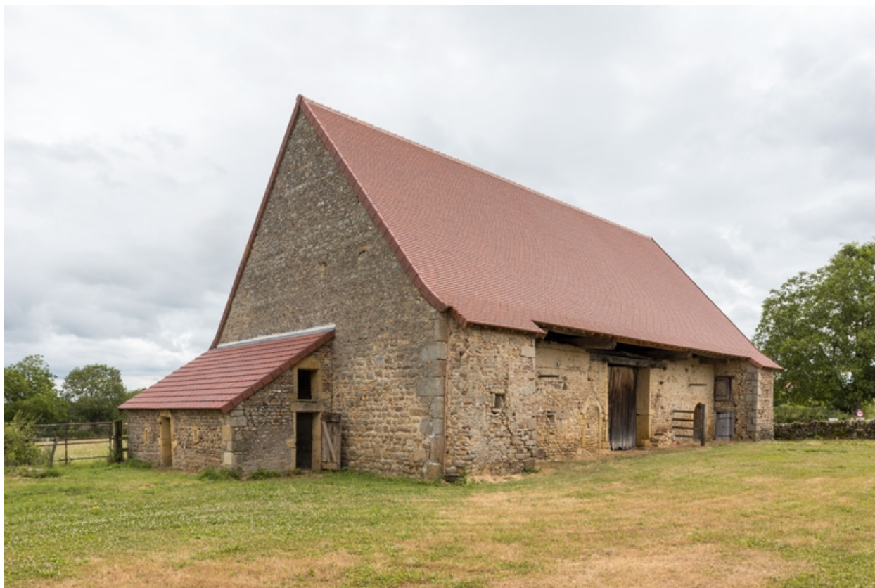
Vue de la grange, depuis l'ouest
