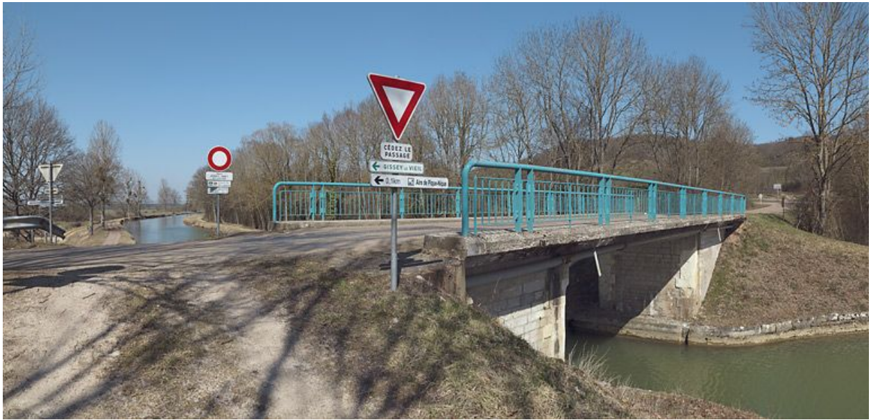
Vue d'ensemble du pont.
