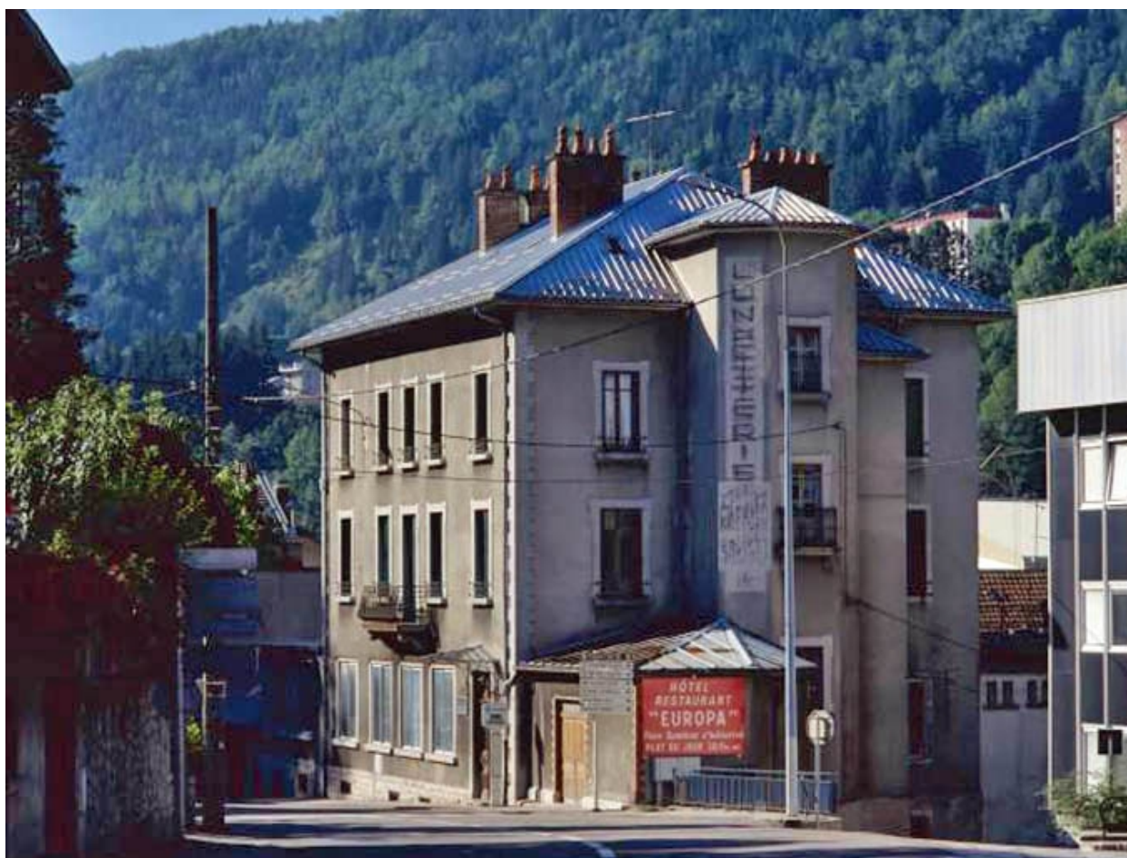
Façades antérieure et latérale droite.
