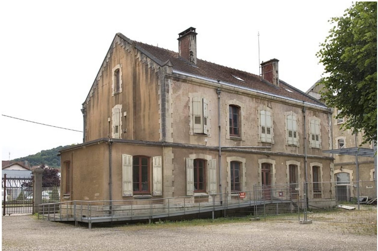
Façade postérieure du bâtiment des bureaux.
