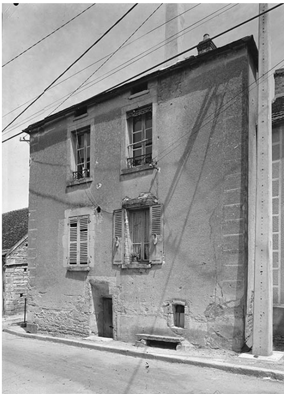
Façade antérieure sur rue.
