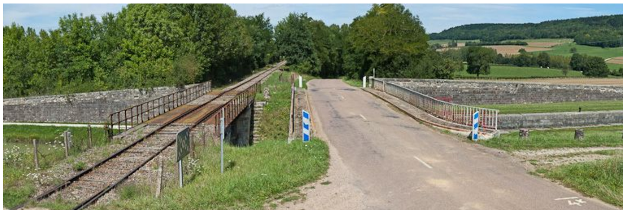
Vue des deux ponts sur écluse.
