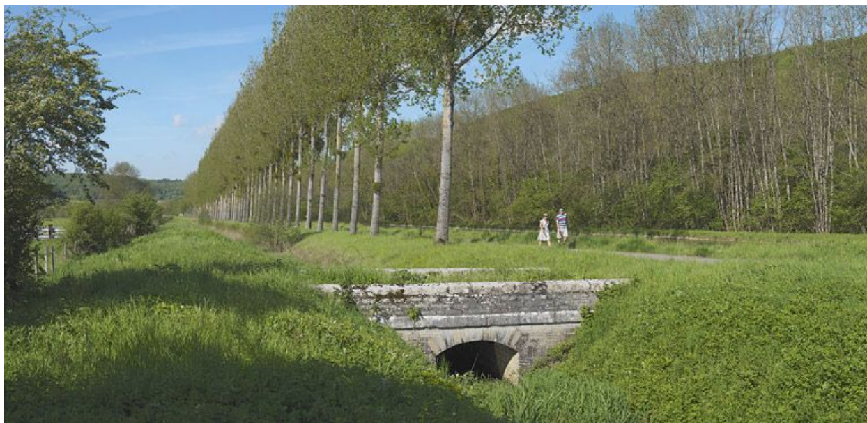
Pont sur rigole rive gauche.
