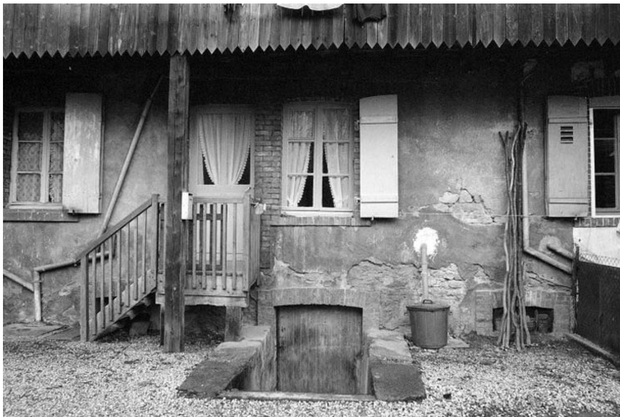
Façade postérieure : détail.
