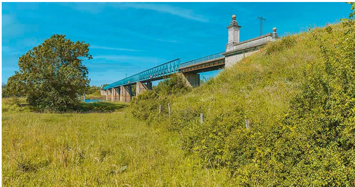
Vue d'ensemble du pont.
