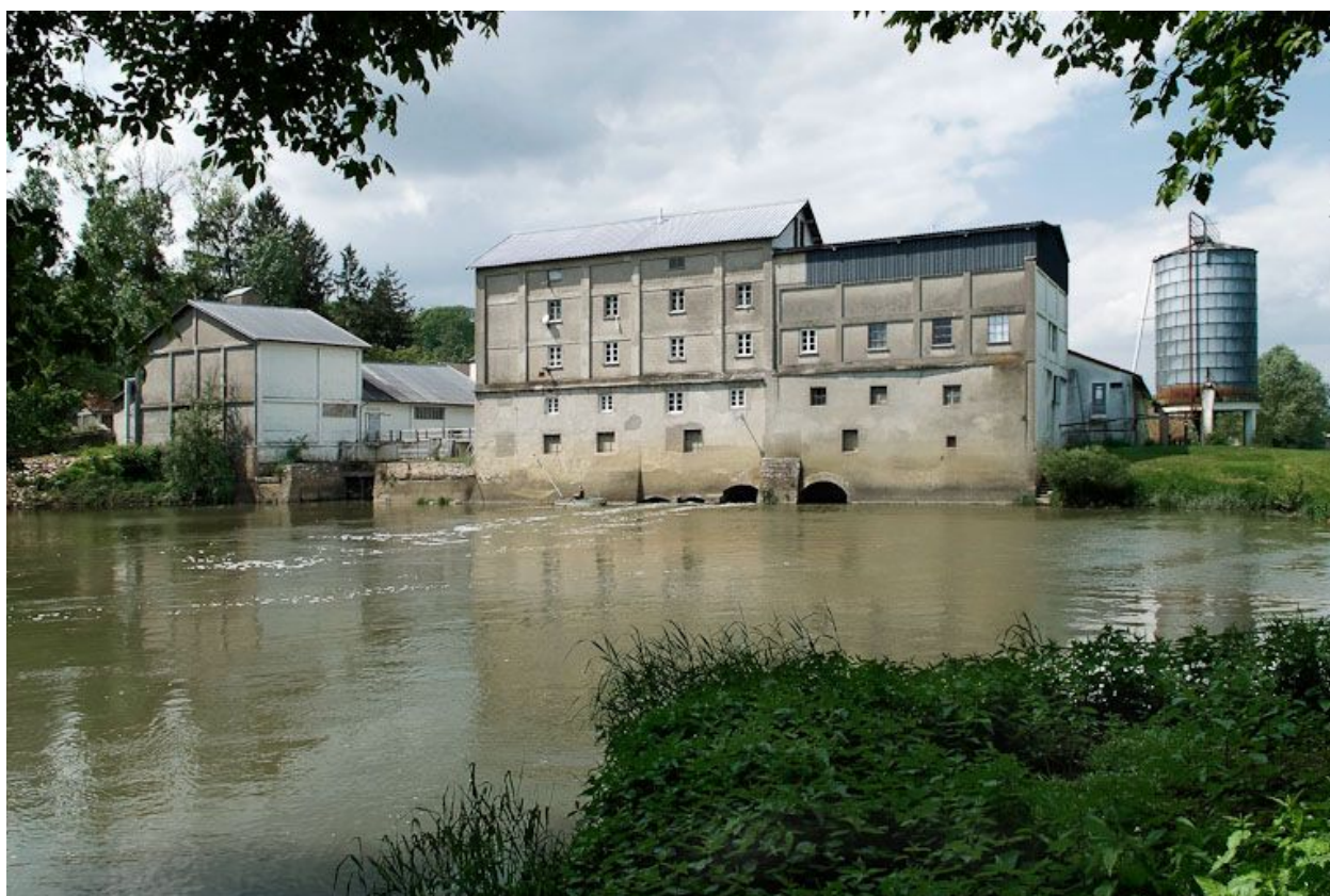
Le moulin : vue d'ensemble d'aval.
