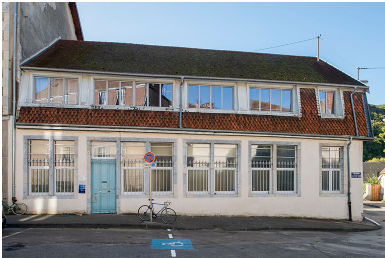
Façade nord de l'atelier.
