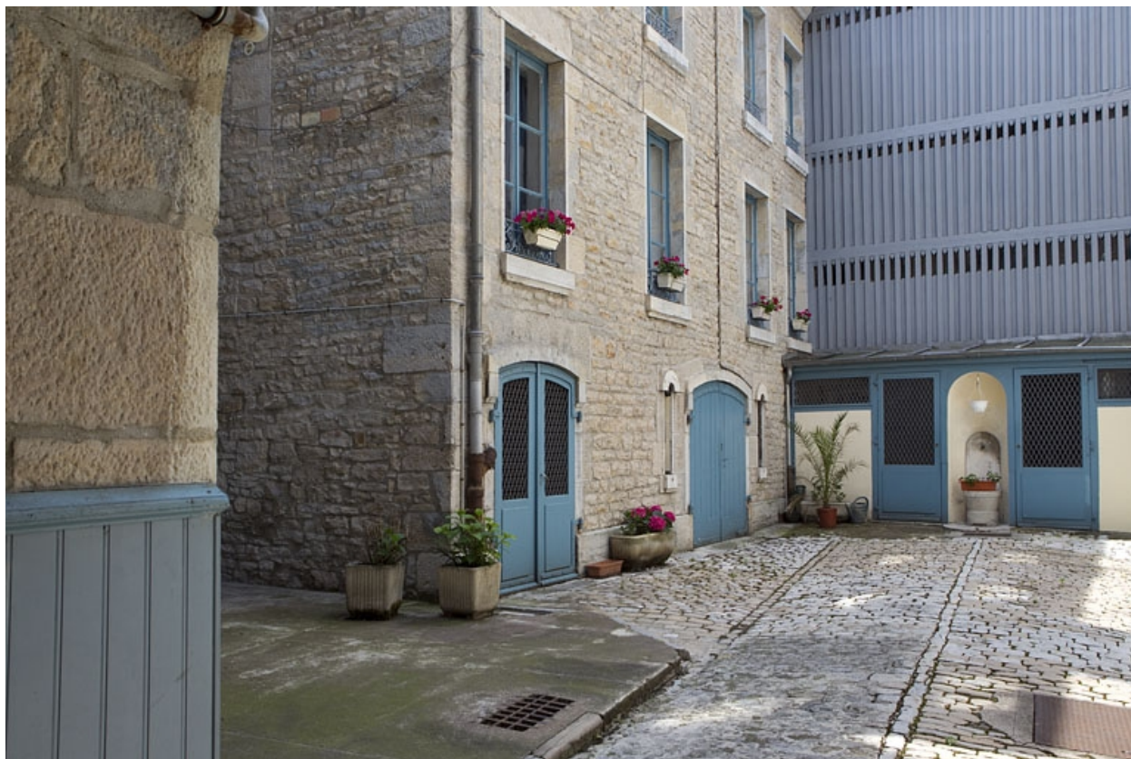
Détail du rez-de-chaussée du logis secondaire gauche.
