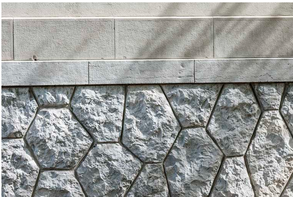
Façade postérieure : détail de l'appareil du soubassement.
