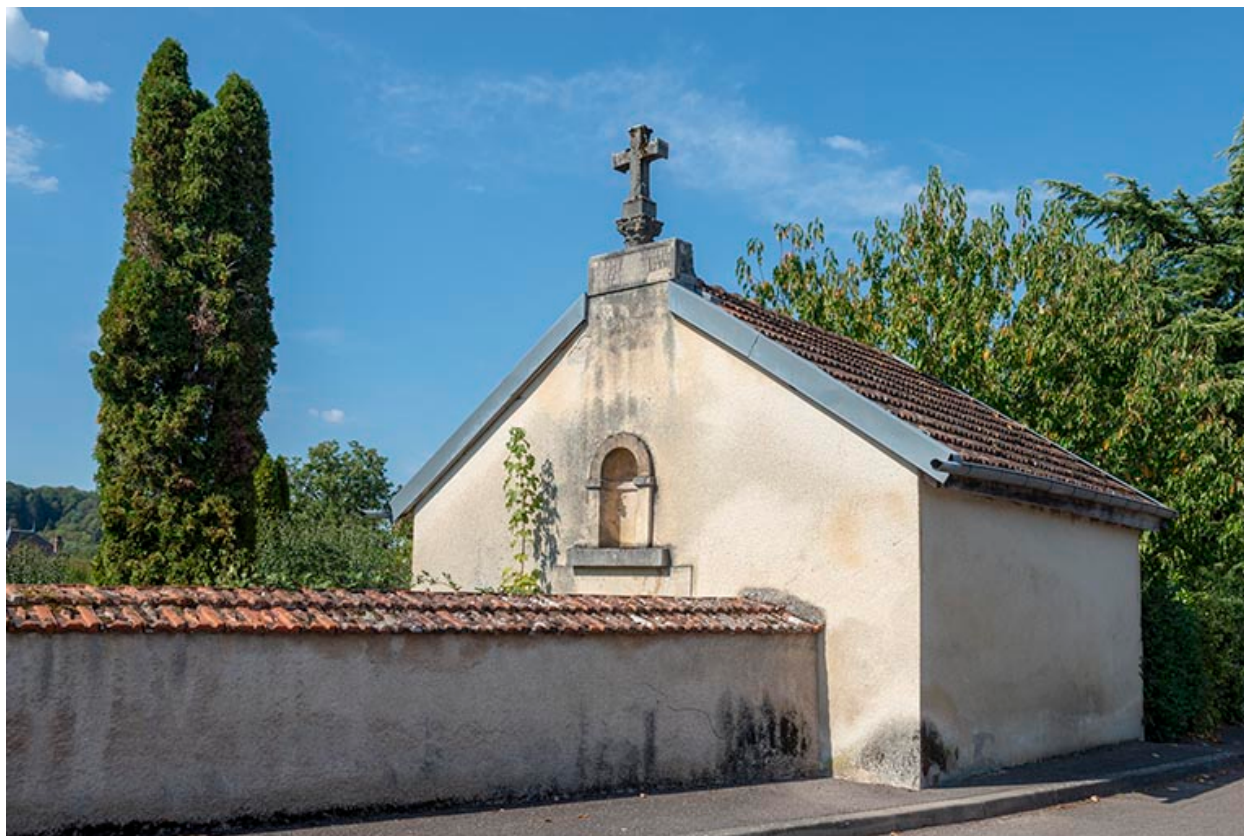
Vue depuis le sud-est.
