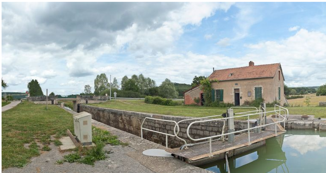
Vue d'ensemble du site d'écluse.
