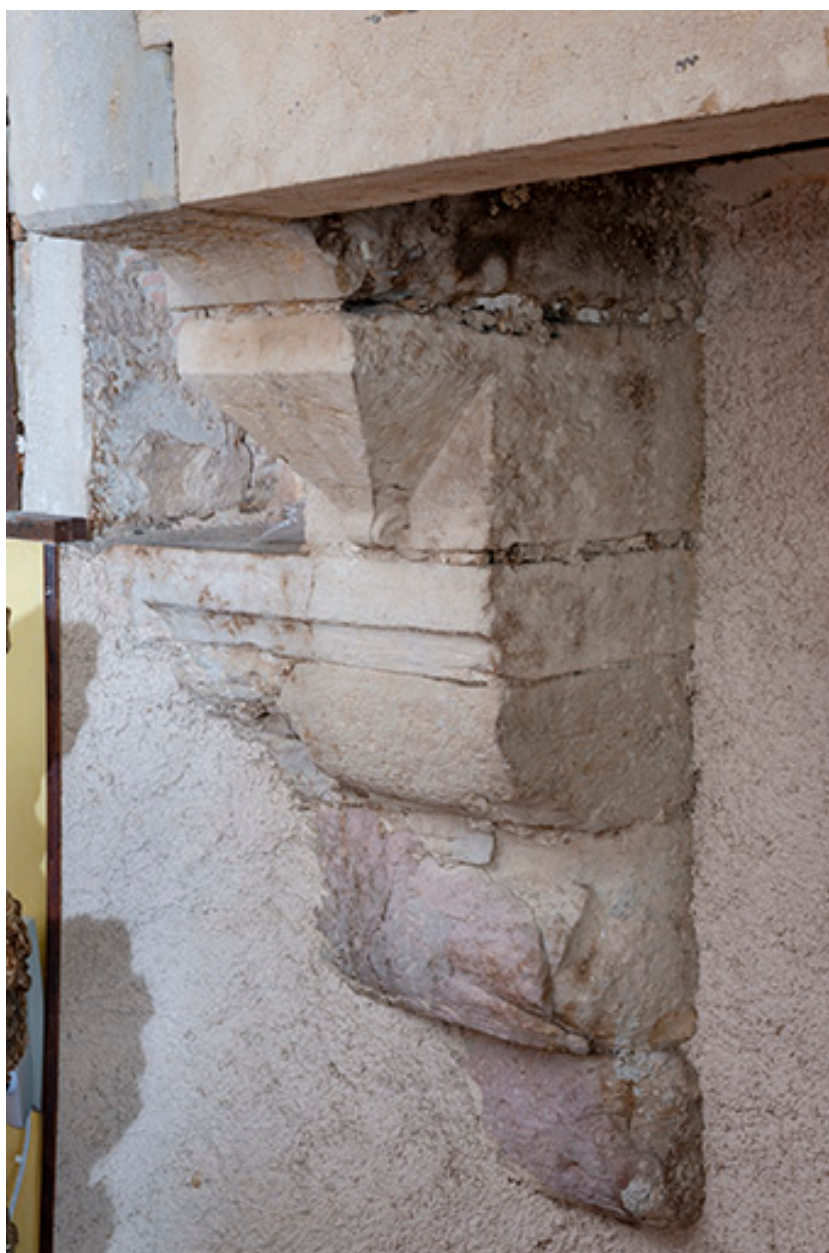
Console supportant la cheminée.
