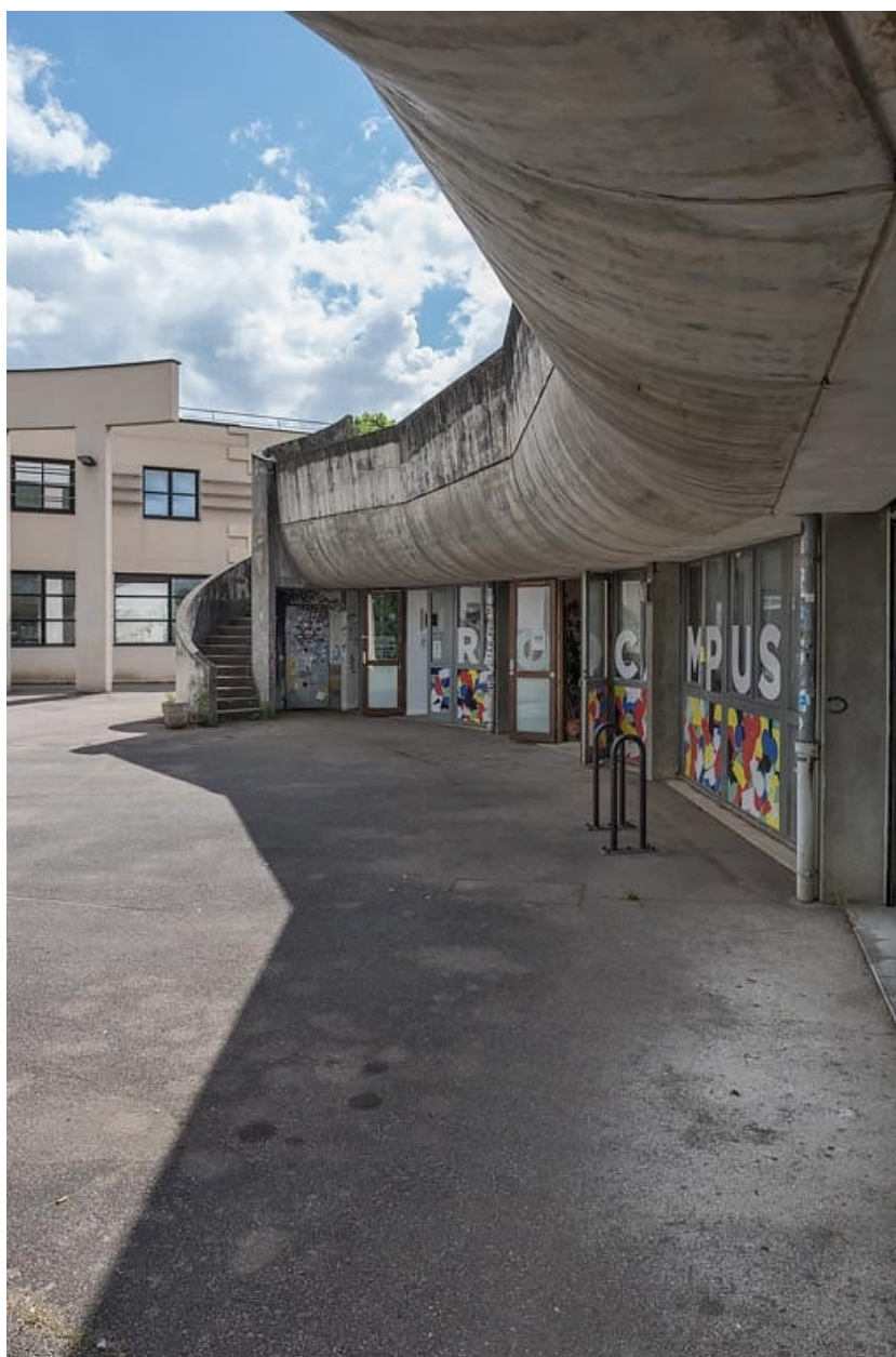
Aile semi-circulaire : toiture formant auvent côté cour.
