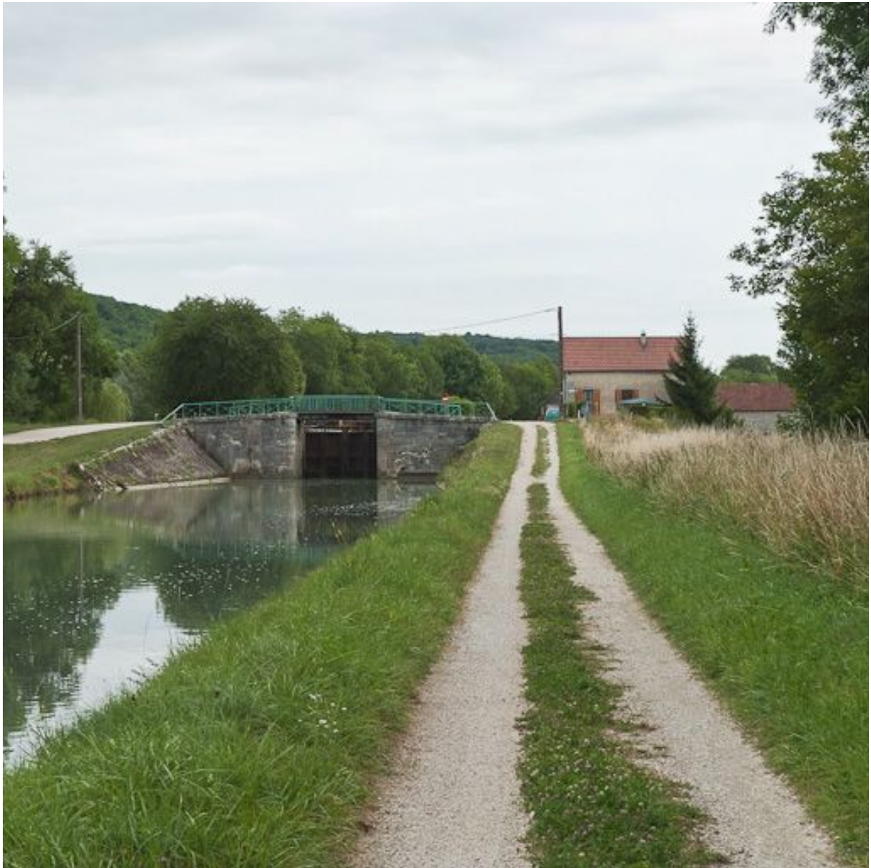
Vue du pont depuis l'aval.
