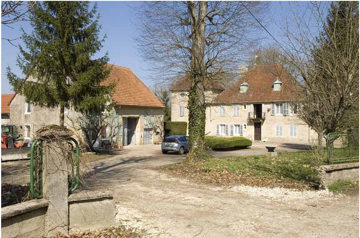
Le logement patronal et ses dépendances.
