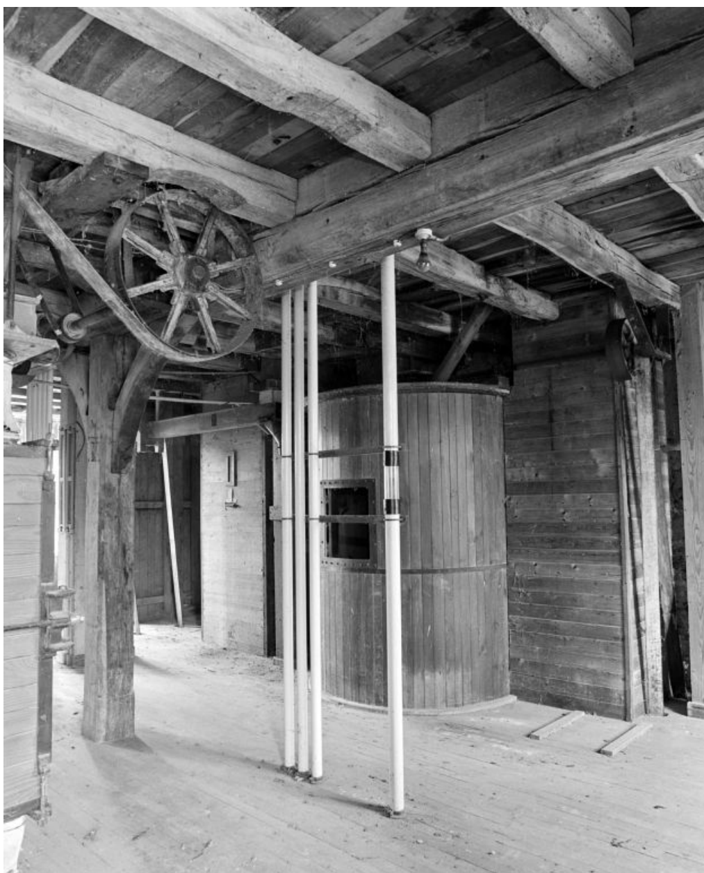
2e étage. Mélangeur.
