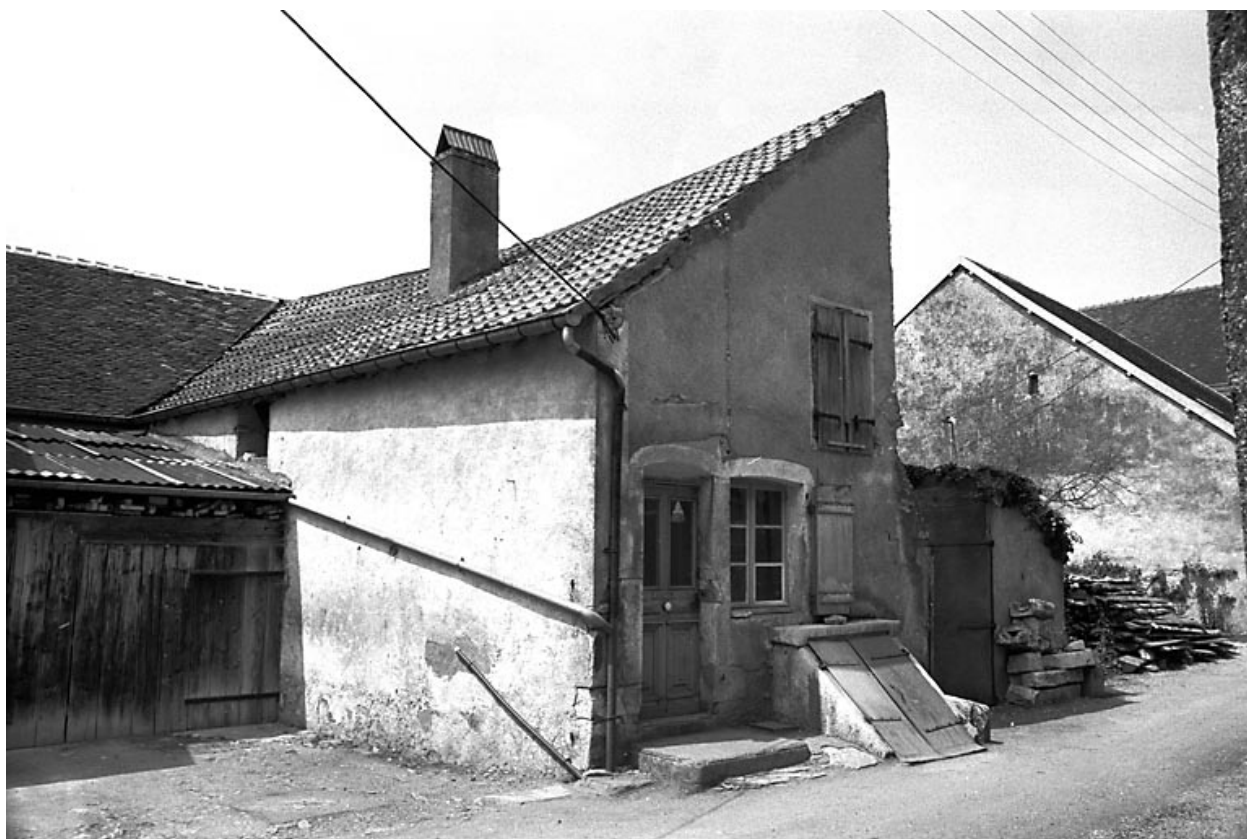
Maison située rue Granvelle : vue d'ensemble.
