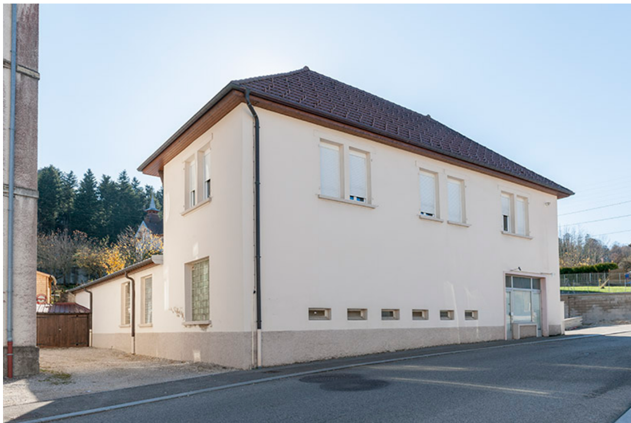
Façades postérieure et latérale gauche.
