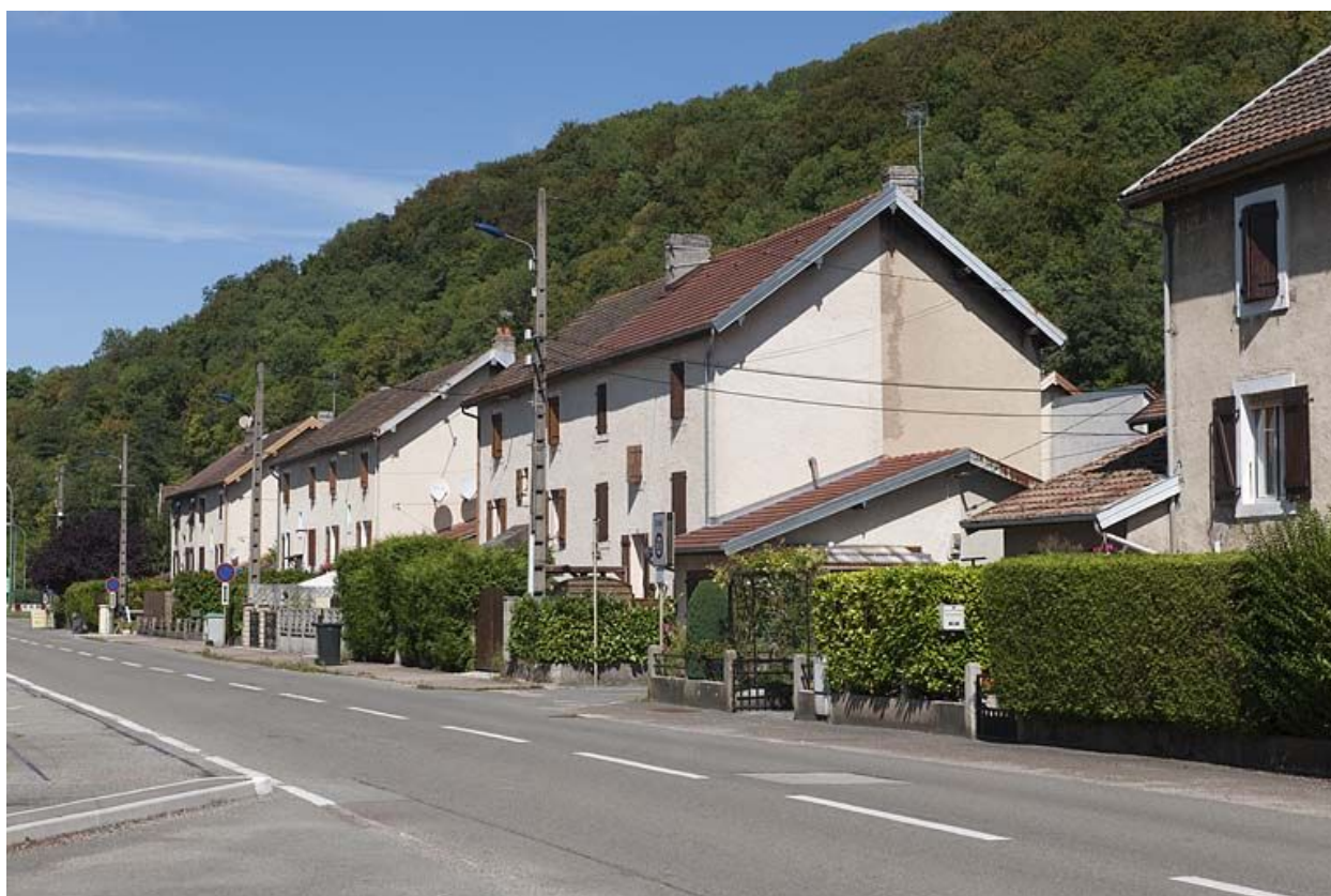
Maisons ouvrières rue des usines.
