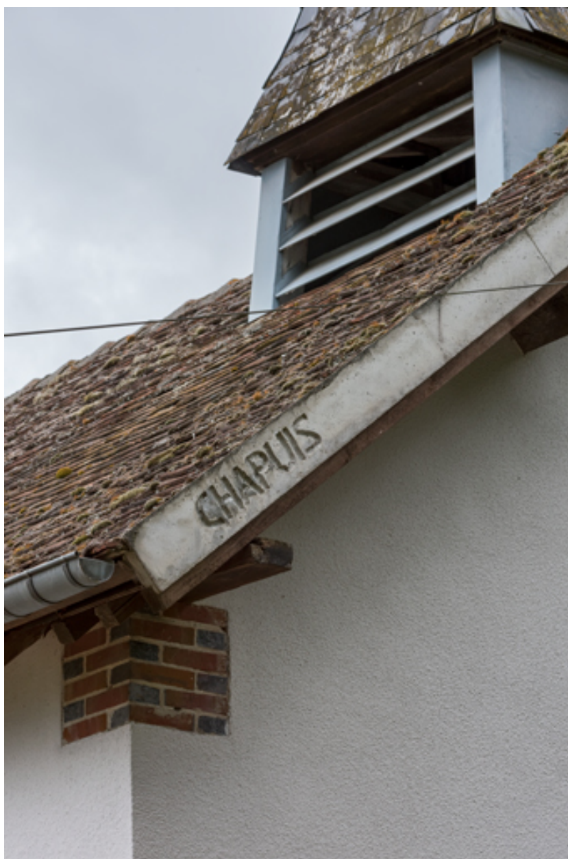
Rampant et rive de la toiture (détail).
