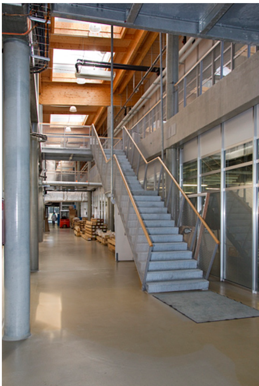
Vaisseau central, au rez-de-chaussée.
