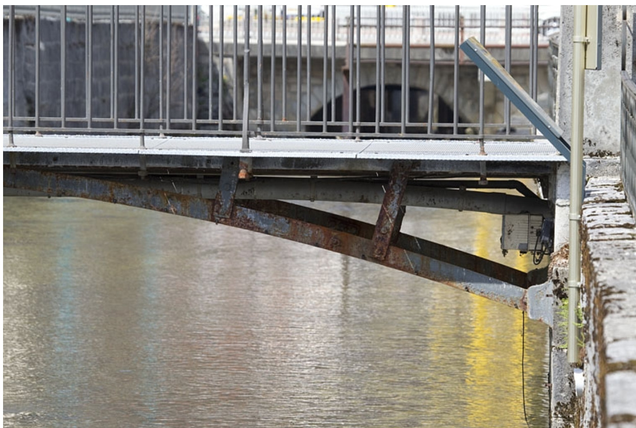
Passerelle aval : détail de l'extrémité rive droite.
