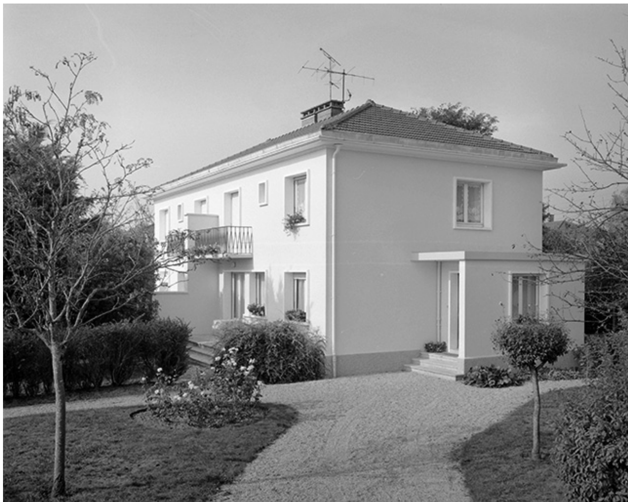
Façade antérieure et face latérale droite.
