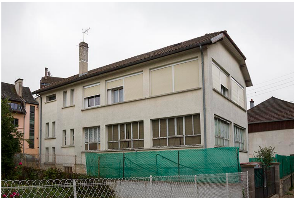
Façades postérieure et latérale gauche.
