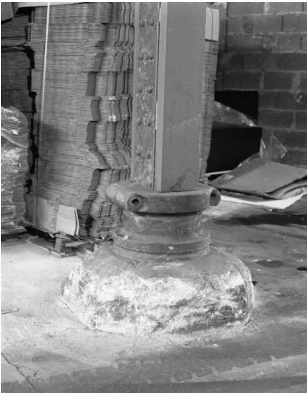
Ancienne fonderie. Base d'un pilier (fonte ?).
