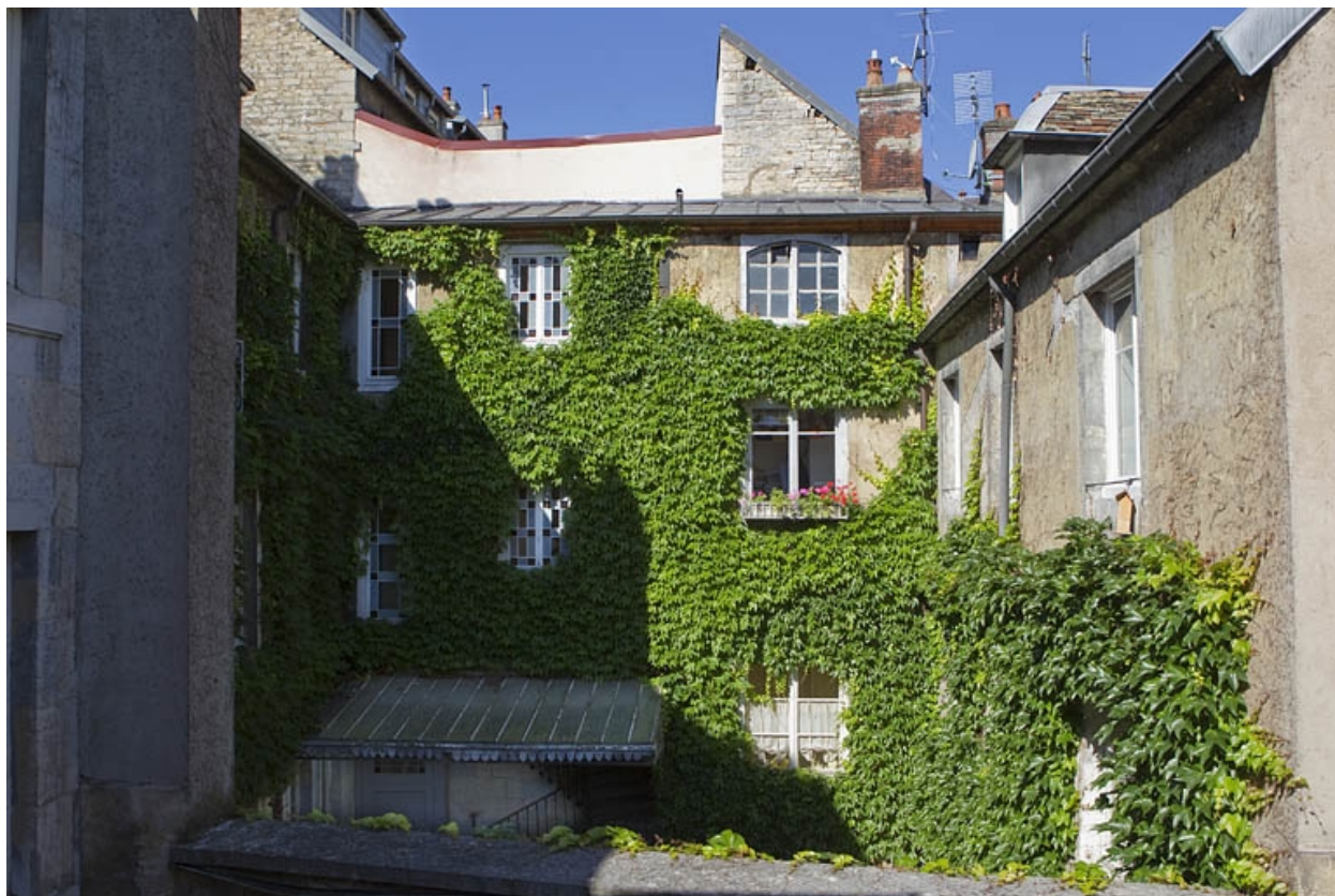
Vue d'ensemble de l'aile contenant l'escalier principal.
