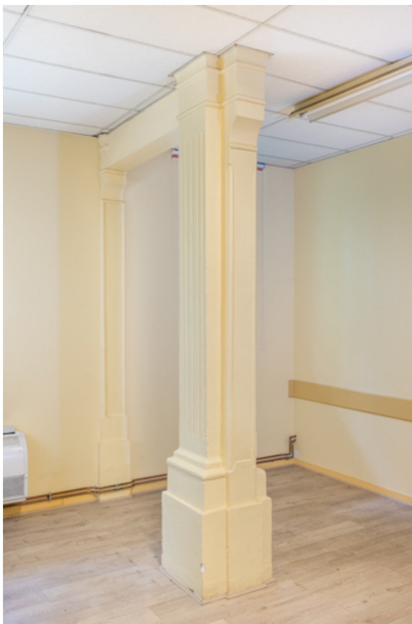
Pilier délimitant l'espace du chœur. Détail.
