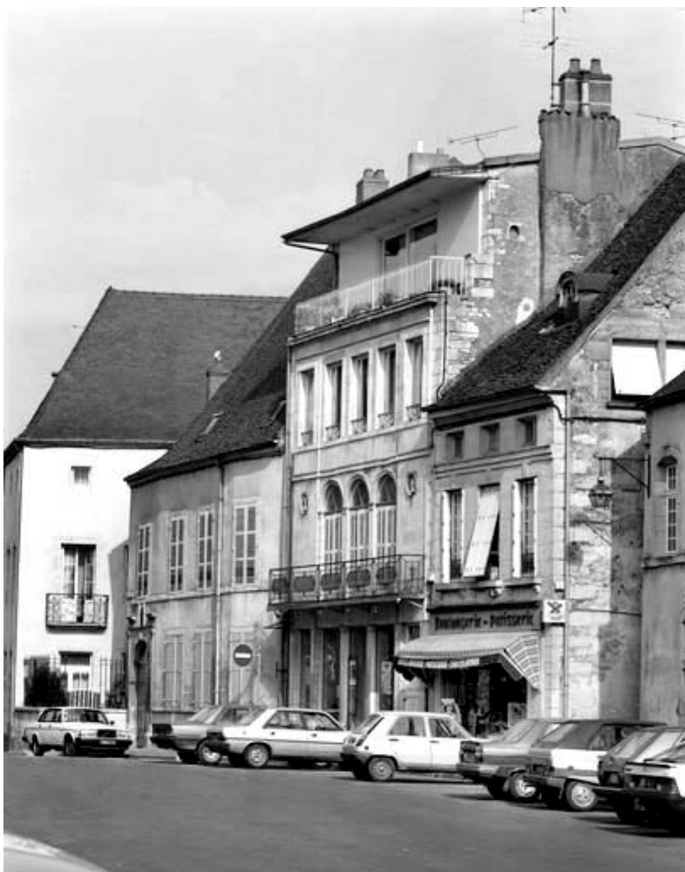
Maison de commerçant située 12 place De Gaulle.
