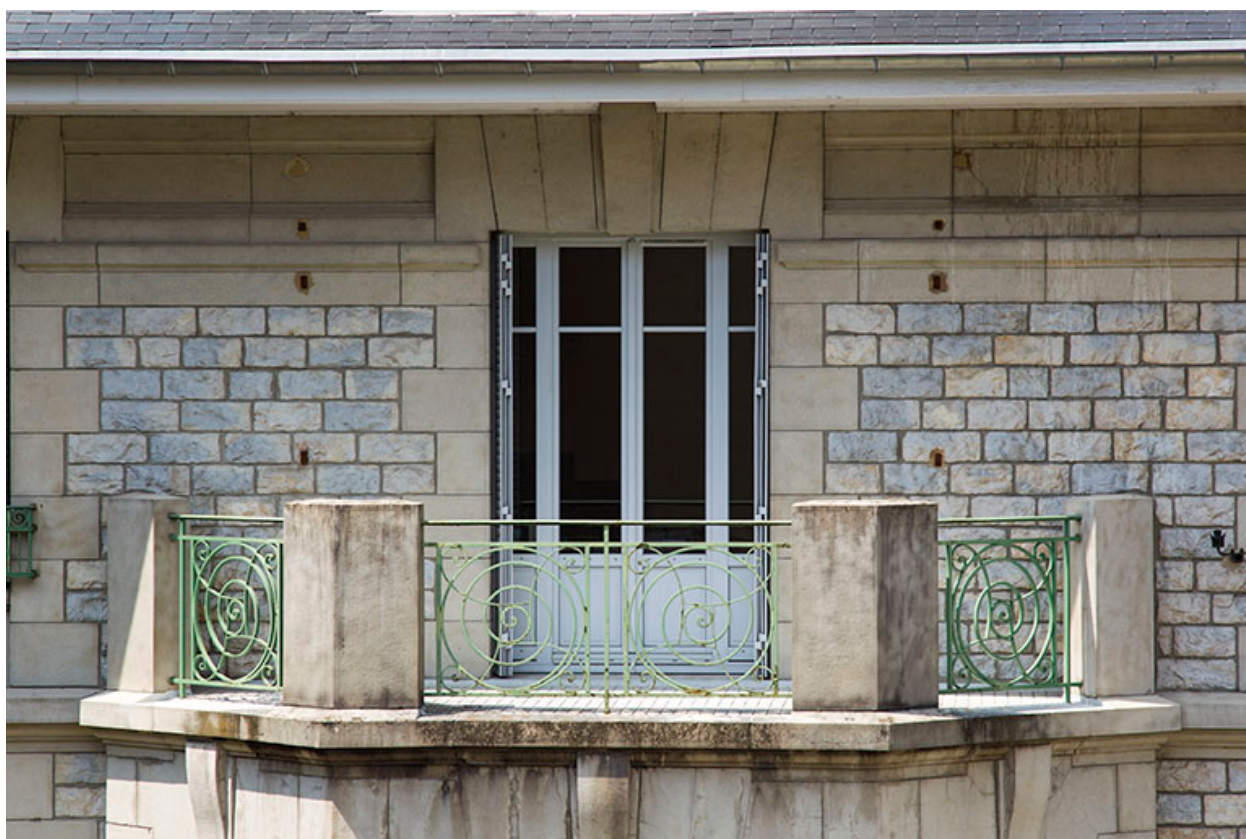
Façade latérale gauche : terrasse surmontant le bow-window.
