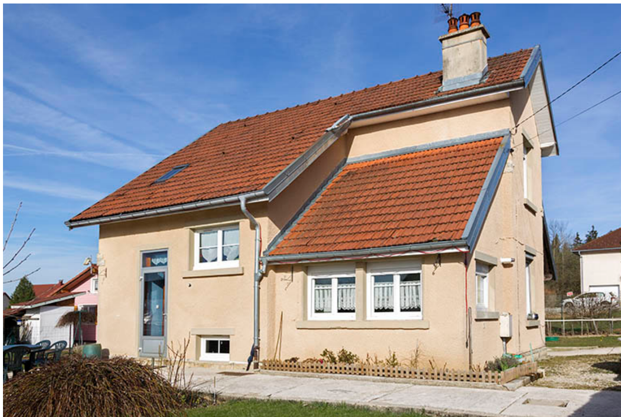
Façades antérieure (pignon) et latérale gauche.
