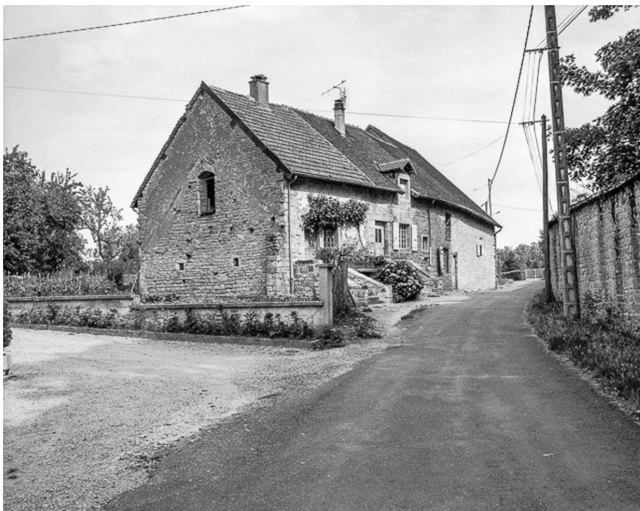
Chilly-le-Vignoble : maison de vigneron.
