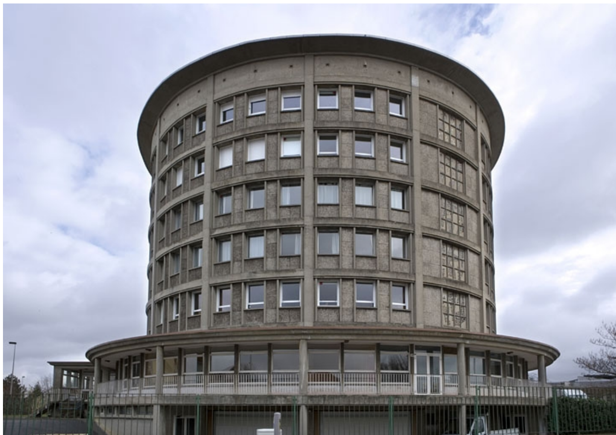
Bâtiment D. Vue de la tour d'internat.
