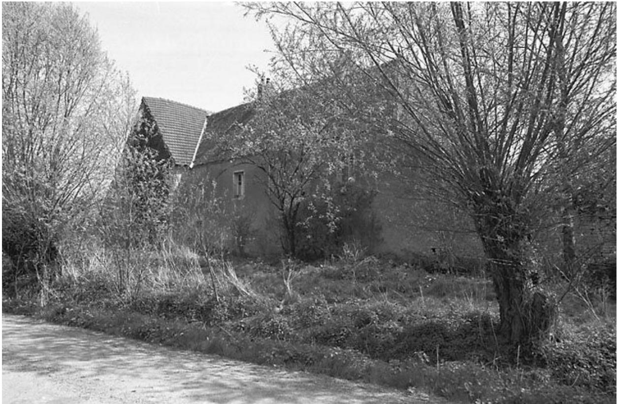
Façade latérale droite.
