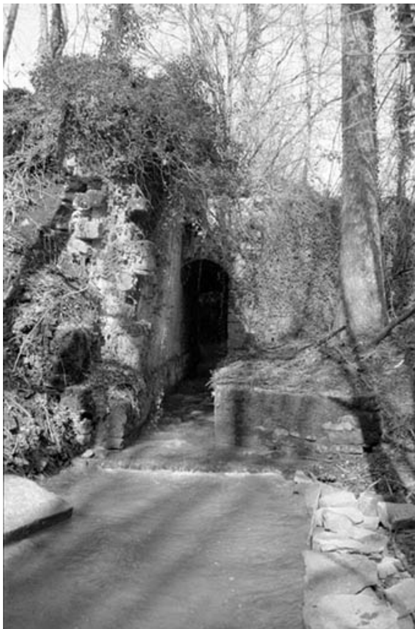
Coursière au débouché du bassin de retenue.
